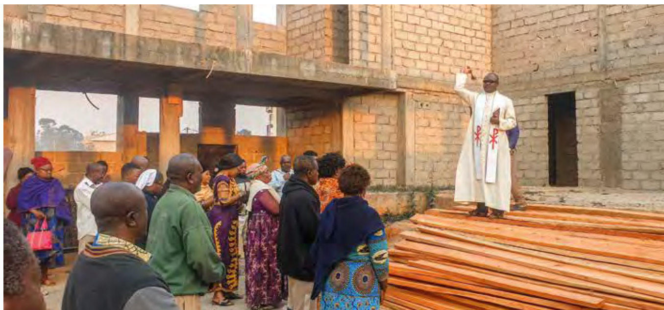
Bendición al comienzo de la cobertura del tejado de la nave polivalente de San Juan Bautista en Nkwen, Bamenda.
