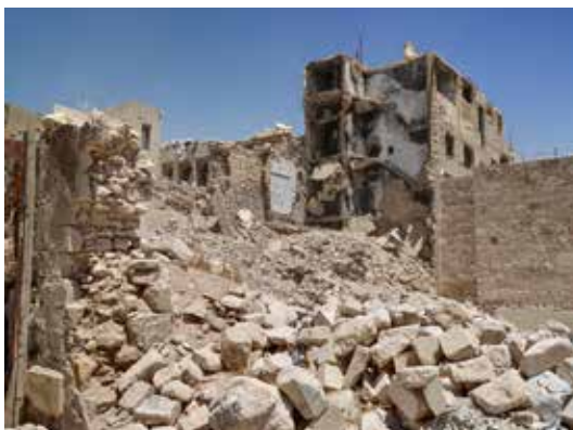
Destrozos en Alepo.
