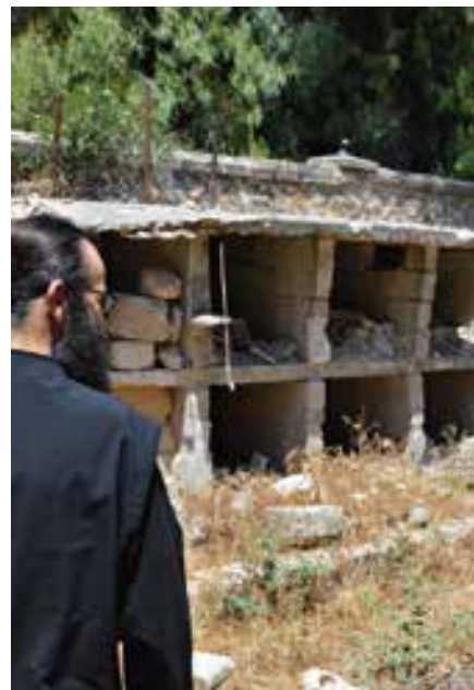
Reparación de un ce- menterio destruido por misiles perteneciente a la archidiócesis ortodoxa griega de Aleppo.
