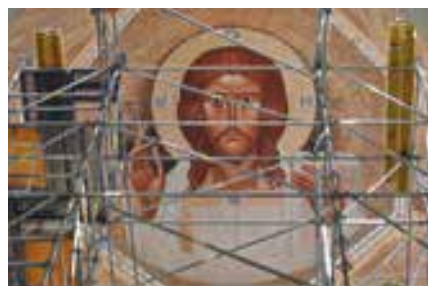
Construcción de la iglesia y del centro pastoral de Sta. Sofía de la Universidad Católica en Leópolis, Ucrania.
