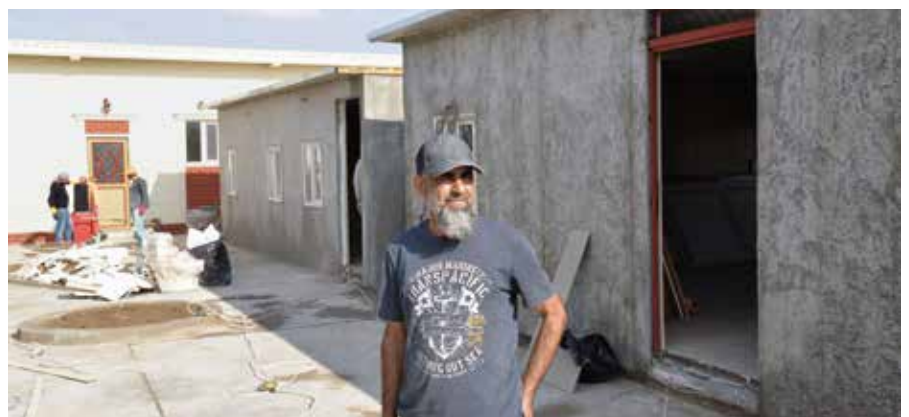
Construcción de nuevas viviendas en Bajdida.
