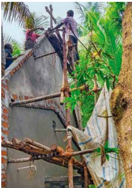
Construcción de la iglesia rural de San José en Ayinapuram.
